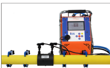
11. Inicio de la soldadura. Start welding.
